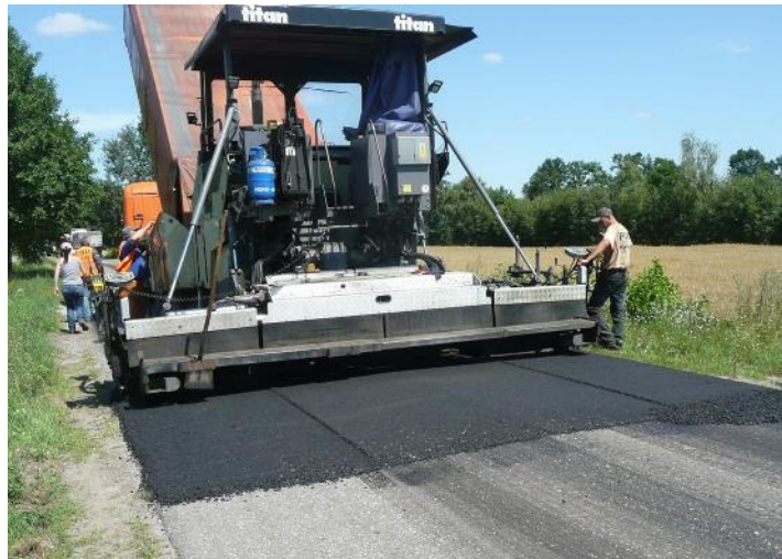
Modernizacja drogi w Bibianie
