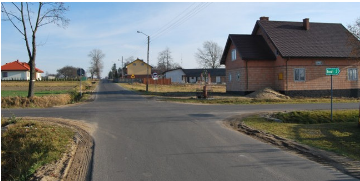
Zmodernizowana droga w Kotwasicach
