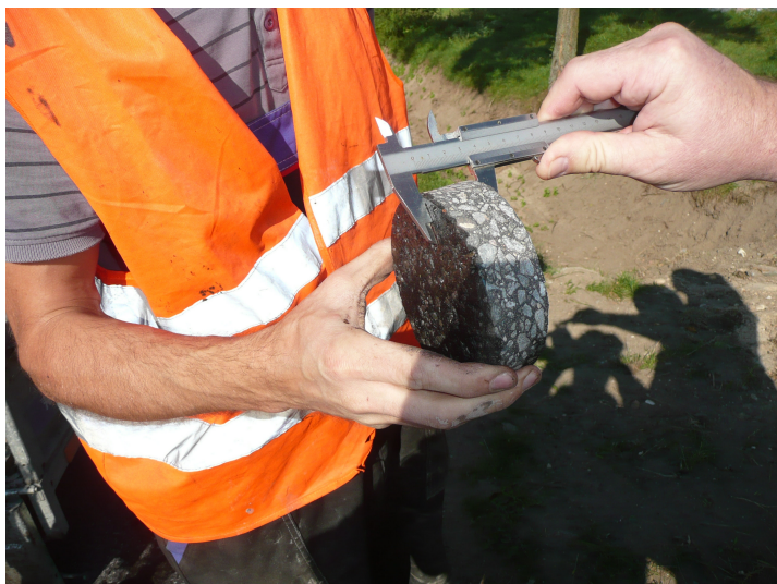
Pomiar grubości asfaltu w Brodach
